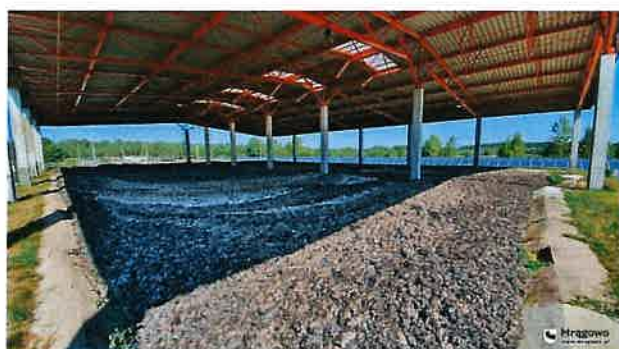
Kompostownia osadów ściekowych
