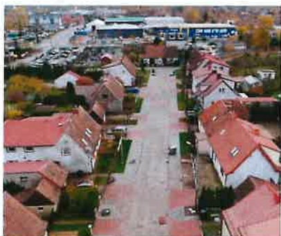
Przebudowa ciągów komunikacyjnych wraz z infrastrukturą techniczną "Na Zatorzu"
