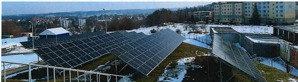
Budowa elektrowni fotowoltaicznej przy Stacji Uzdatniania Wody na osiedlu Mazurskim w Mrągowie
