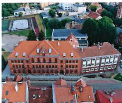
Budynek SP Nr 1 po termomodernizacji
